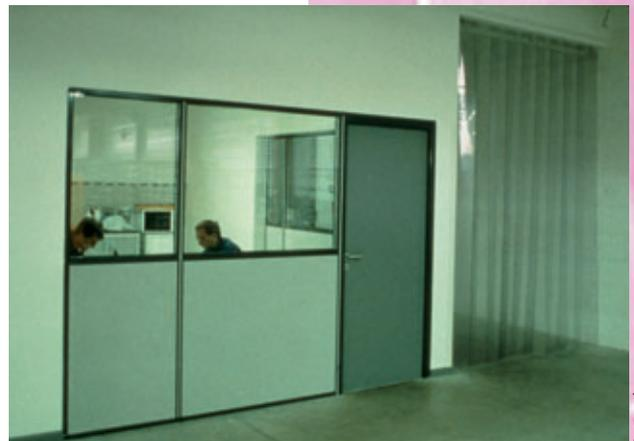
*Cloisonnement de protection d'une zone de repos*
